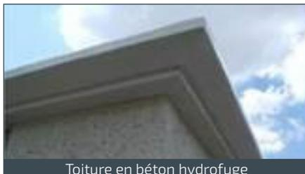
Toiture en béton hydrofuge
